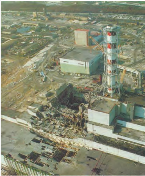
↑ Зруйнований четвертий реактор ЧАЕС
